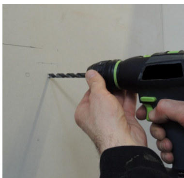
Perçage du mur (c)
