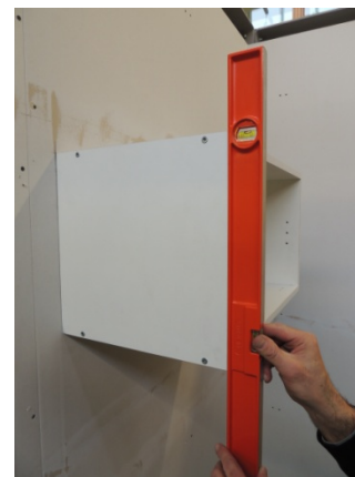
Contrôle de l'aplomb (c)
