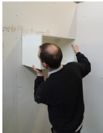
Mise en place du meuble (a)
