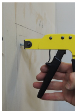
Mise en place des chevilles (d)
