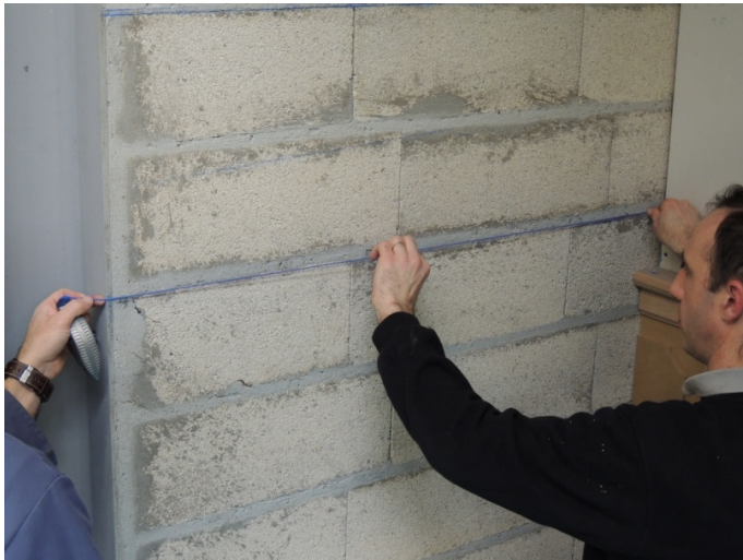
Traçage du trait de niveau à l'aide d'un cordeau
