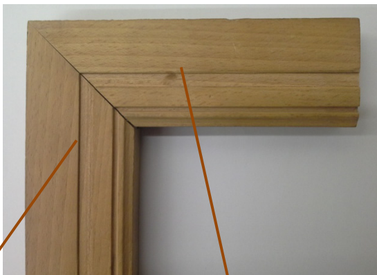
Enfourchement avec flottage d'onglet
